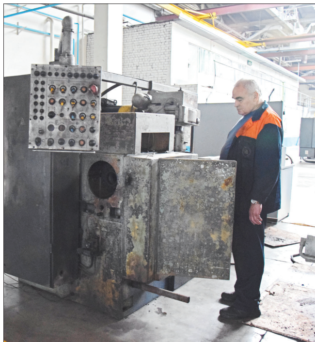
Слесарь-ремонтник СЭиРОиС Анатолий ВАЛЯЕВ производит осмотр станка ВС-52
