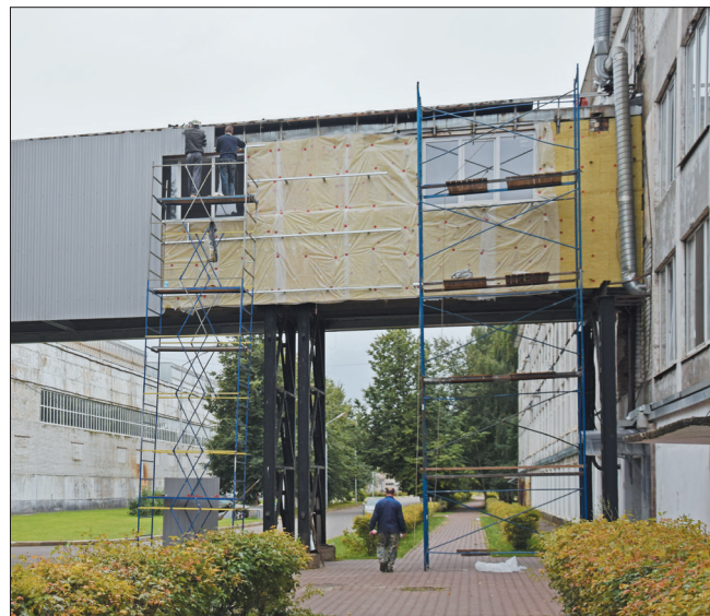
Завершается ремонт галереи
