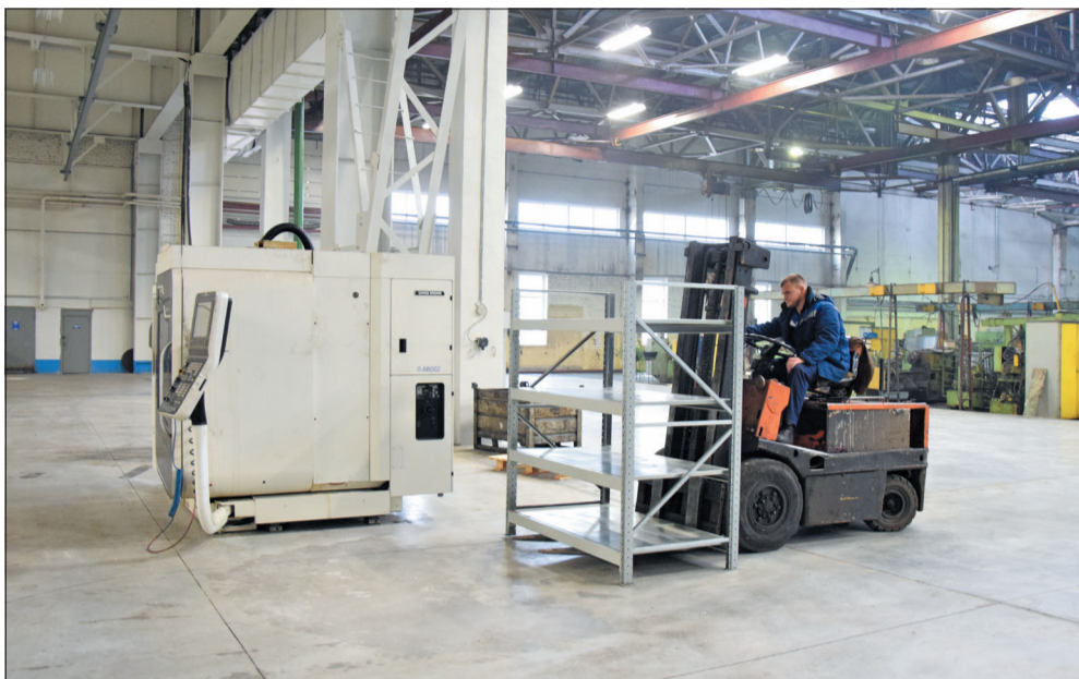
Идёт установка оборудования на новом участке в МСЦ
