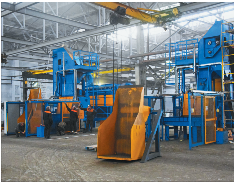
Монтаж дробемётных барабанов
