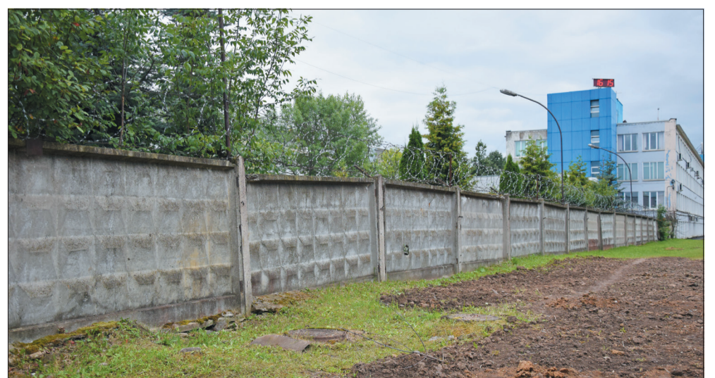
28 августа. Старые железобетонные конструкции сейчас демонтированы
