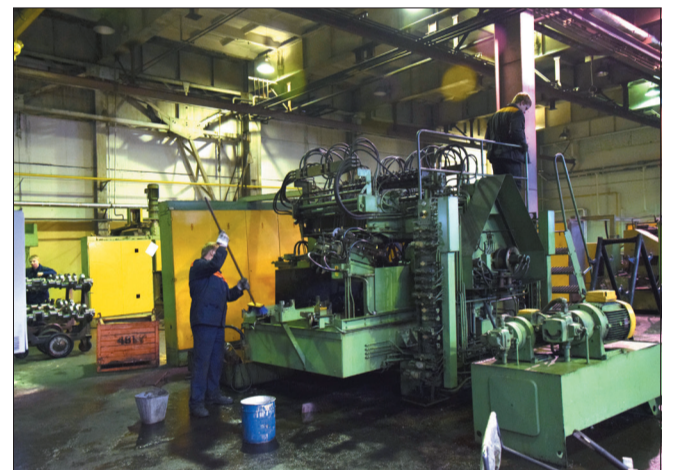
Подготовка оборудования к ремонту в МСЦ
