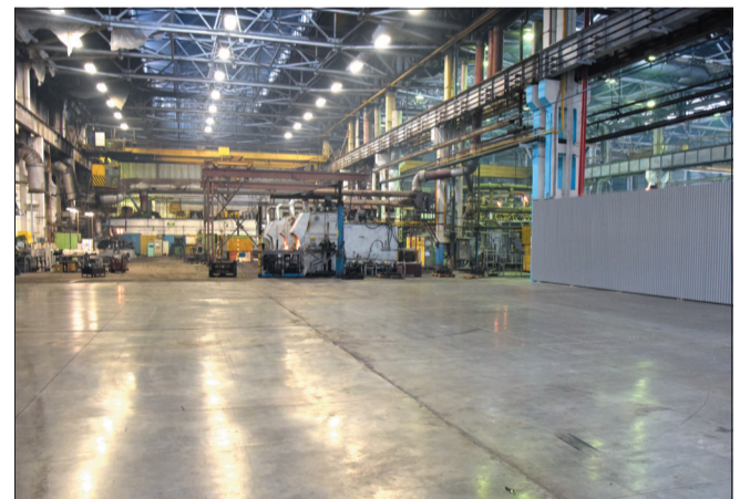
Подготовлены площади для перемещения участка финишной обработки коленчатого вала в МСЦ
