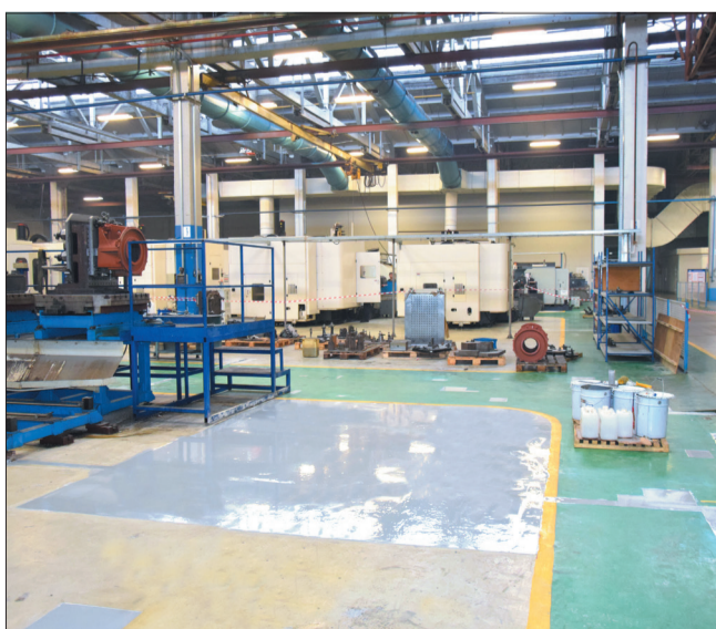
Идёт подготовка площадей под новое оборудование на участке обрабатывающих центров в ЦДДиКП
